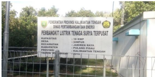
Pembangkit Tenaga Surya (PLTS)
